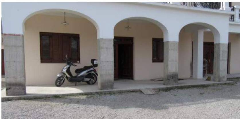
Slika 1. Pročelje građevine i ulaz u prostor prizemlja
